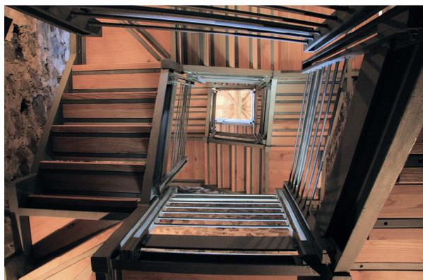
L'intervento ha comportato, oltre al rifacimento del manto di copertura e il risanamento della sua struttura lignea, la realizzazione di una scala in acciaio con gradini in castagno. La scelta architettonica relativa alla tipologia della scala è stata determinata dalla necessità di avere un elemento staccato dalla struttura originaria, in modo da poter mettere in evidenza la muratura perimetrale con i relativi elementi (tessitura e fori pontai), per tutta la sua altezza.
